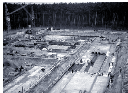
Bau des ITU 1963
