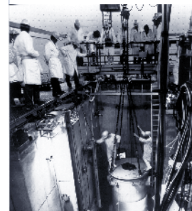
Die Erneuerung des Reaktordruckbehälters 1984 ebnete den Weg für neue Bestrahlungsmöglichkeiten.
