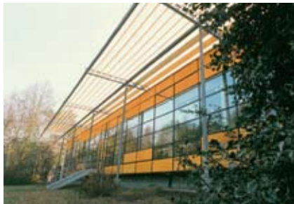
Das umgebaute Mensa-Gebäude (Ispra), Februar 1996.
