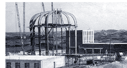
Construcción del reactor HFR en Petten.
