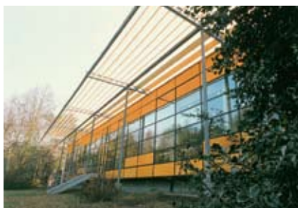
El edificio Mensa (Ispra) reformado (febrero de 1996).
