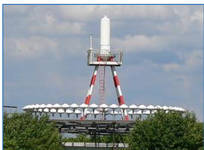
Figura 48 – Sito VOR/DME (DME in torre) (Crediti: Hans-Peter Scholz, soggetta a licenza Creative Commons )
