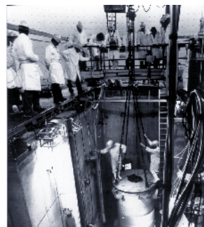
Met de vervanging van het reactordrukvat in 1984 werd de weg geëffend voor nieuwe bestralingsmogelijkheden.
