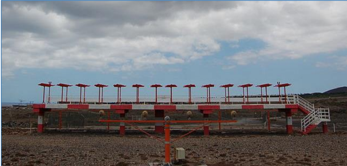
Abbildung 49 – ILS (Landekursender) (Quelle: Super Dominicano, unter der GNU-Free-Dokumentation-Lizenz )
