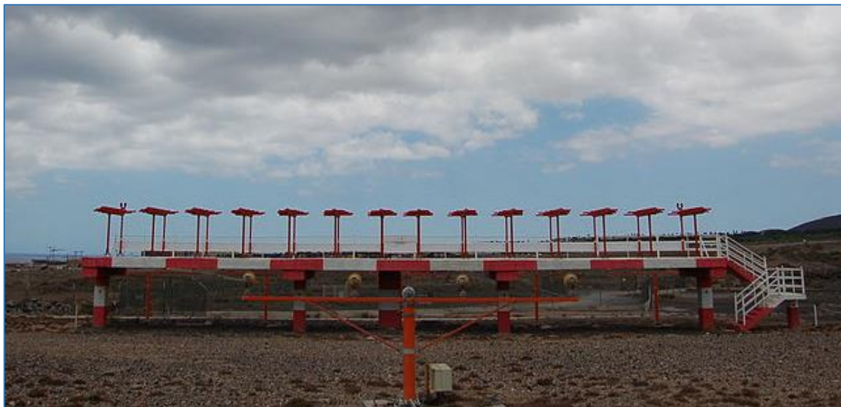
Gráfico 49. ILS (LOC) (fuente: Super Dominicano, bajo licencia de documentación libre de GNU )
