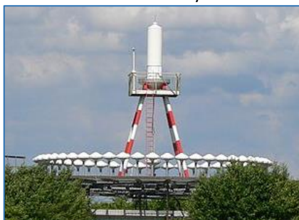
Gráfico 48. Emplazamiento con VOR/DME (DME en la torre) (fuente: Hans-Peter Scholz, bajo licencia Creative Commons )
