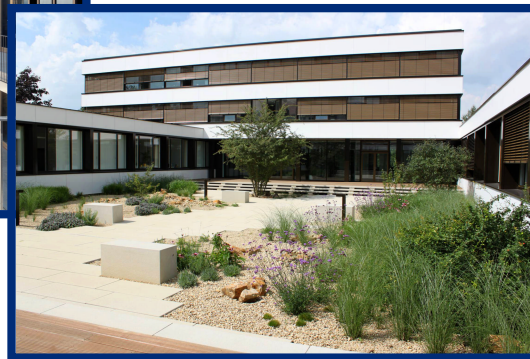
Leibniz-Institut für ökologische Raumentwicklung e.V. (IÖR), DE, Refurbished Building, Winner 2012
